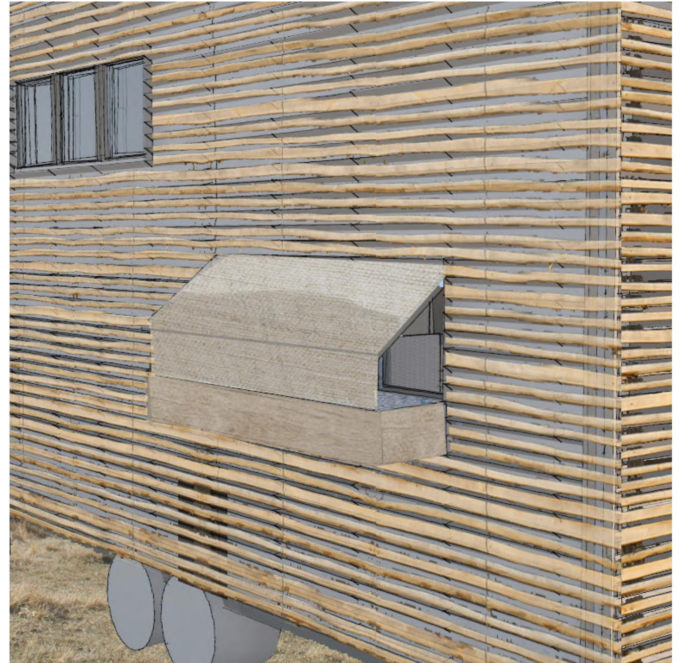
Un haut châssis à soufflet à l'italienne ventile généreusement l'espace douche/toilettes sèches sur la façade côté timon.
